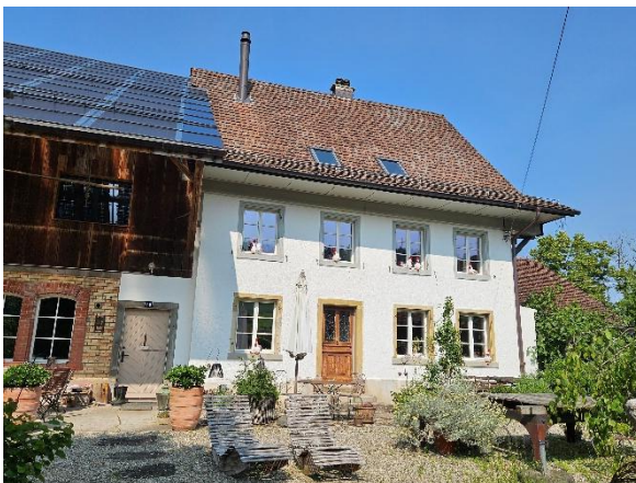
Abbildung 17 Wohnhaus (ohne Scheunenteil), Waldhausen (Gebäude Nr. 78 / Parzelle Nr. 451) (Quelle: Gemeinde Fisibach)
