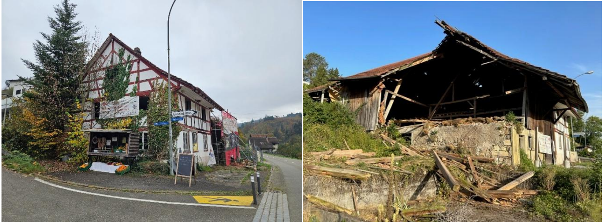
Abbildung 11 Wohnhaus und Stall (ohne Anbau) (Gebäude Nr. 4 / Parzelle Nr. 96). (Quelle: Gemeinde Fisibach)
