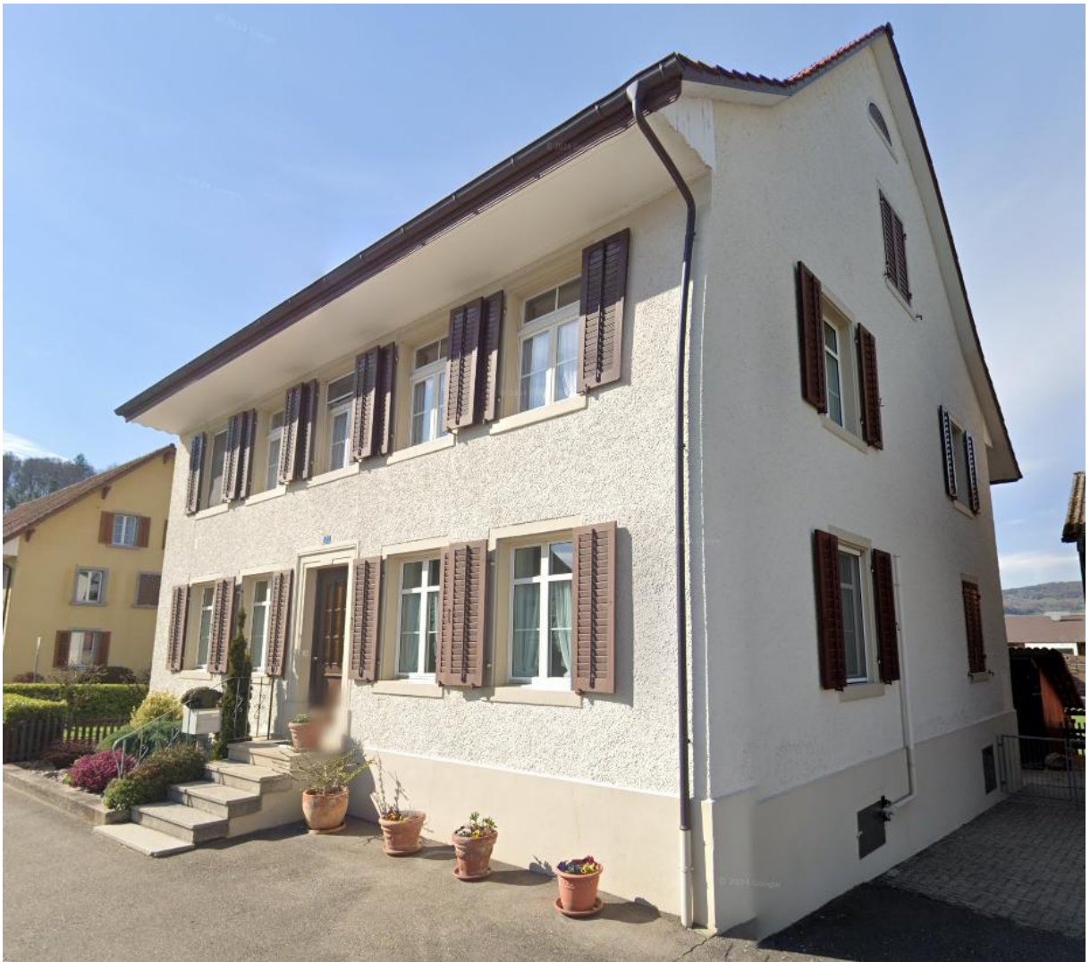
Abbildung 12 Haus Belchenstrasse (Gebäude Nr. 20 / Parzelle Nr. 186) (Quelle: Google Street View)
