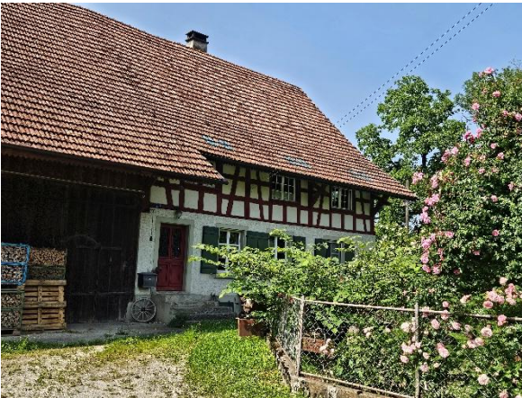
Abbildung 16 Wohnhaus (ohne Scheunenteil), Waldhausen (Gebäude Nr. 76 / Parzelle Nr. 450) (Quelle: Gemeinde Fisibach)
