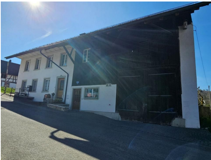
Abbildung 10 Ehemaliges Bauernhaus (Gohl), Dorfstrasse (Gebäude Nr. 9 / Parzelle Nr. 92) (Quelle: Gemeinde Fisibach)
