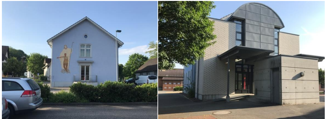
Abbildung 5: Schulhaus Belchen (Fotos: Metron)
