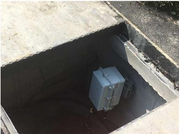
Abb. 1: Glasfaser-Erschliessung bis zum Schacht (FTTS)
